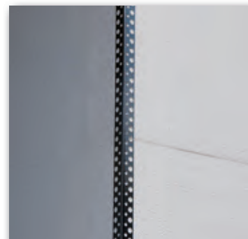
Profilé d'angle Aluminium en situation
