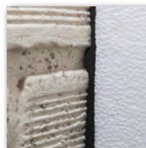
Compriband® TRS PC en situation
