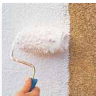
5 Après cet assainissement fongicide et algicide, le fond peut être mis en peinture
