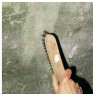
1 Le nettoyage : Brossage à sec
