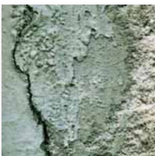
10 Salpêtre crypto-efflorescences
