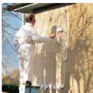
3 Application au rouleau du LIQUIDE 542 : mouiller abondamment les fonds avec le produit
