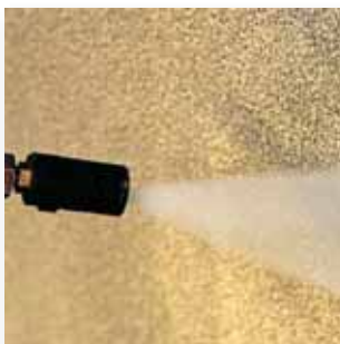
2 Lavage à l'eau sous pression
