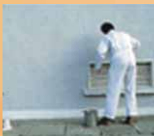
5 Surface taguée après nettoyage.
