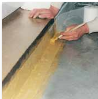
Collage du GALON PANTITEC avec PANTITEC RENFORT
