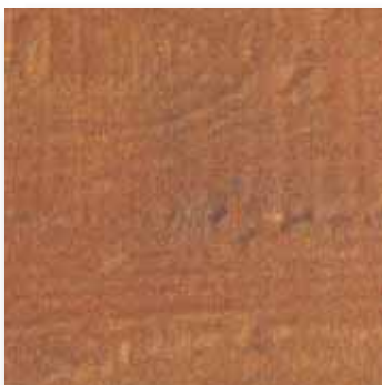
14 État de parement : élémentaire Béton branché (branche = coffrage en bois brut)
