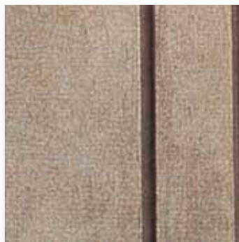
15 État de parement : très soigné Béton moulé Béton architectonique
