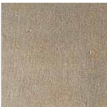
18 État de parement : soigné Planitude sous règle de 2 m \leq 5 mm Planitude sous réglet de 20 cm \leq 2 mm. Les désaffleurs ne doivent pas dépasser 3 mm Avec un linéaire < 50 cm par m 2 . Arêtes et cueillies rectifiées et dressées Bulles < 3 cm 2 Étendue en surface < 10 %
