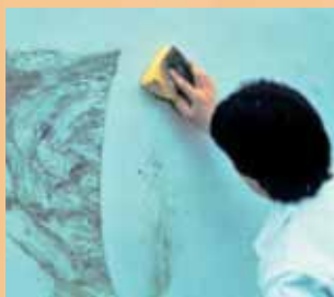
4 Essuyage du nettoyant et rinçage à l'eau. Sur grandes surfaces, préférer un rinçage à l'eau sous pression.
