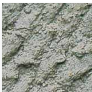
28 Jeté à la truelle, permettant des empâtements grossiers.
