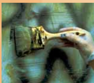
2 Application de PARAGRAF NETTOYANT 764 en couche épaisse (produit gélifié).
